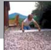
Tipas AL: Grubios medžiagos dangos išlyginimas.
