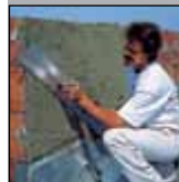
Tipas HAK: Nutinkuotų paviršių lyginimas.
